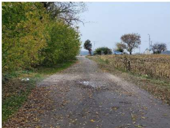
Foto 5. Widok ulicy Dworskiej w kierunku ulicy Nadarzyńskiej
