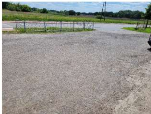
Foto 12. Utwardzenie przed budynkiem
