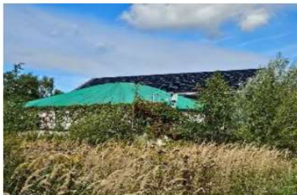
Foto 1. Widok na oczyszczalnię ścieków
